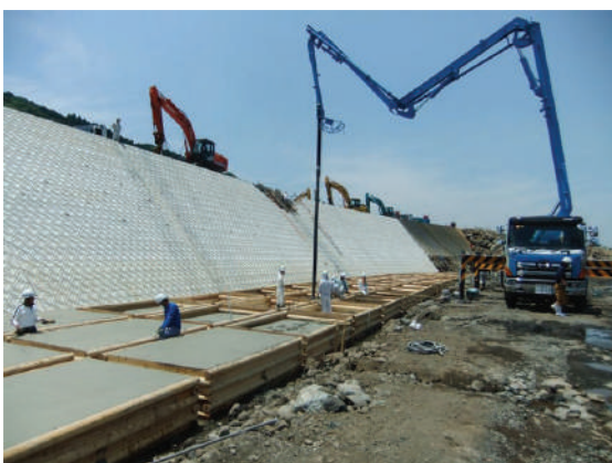
生コンクリート打設状況
