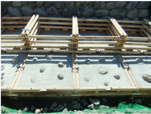
国交省 筑後川河川事務所 花月川 (ウッドロック工法+木工沈床)
