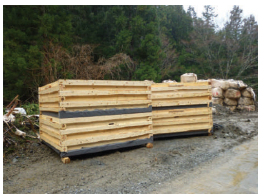
山梨県 菅野川 災害復旧工事
