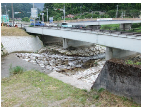
鳥取県 小江尾川 (橋梁下部)
