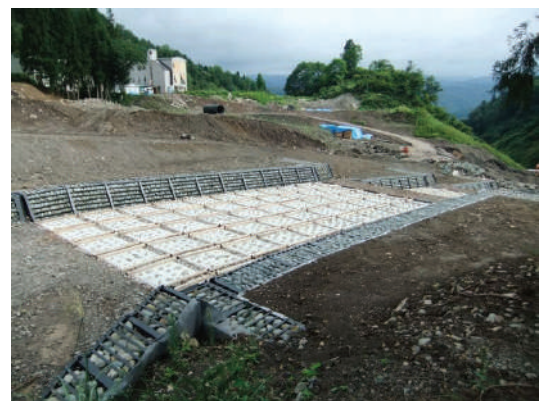
国交省 筑後川河川事務所 花月川 (ウッドロック工法+木工沈床)
