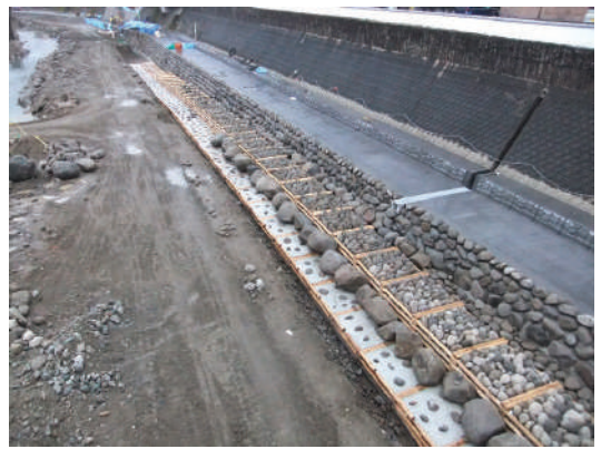
国交省 筑後川河川事務所 花月川 (ウッドロック工法+木工沈床)
