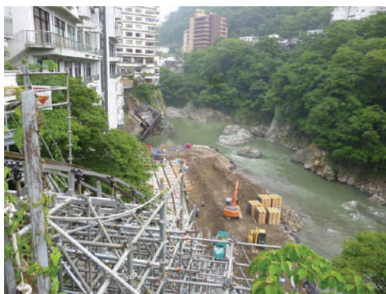
施工現場全景
