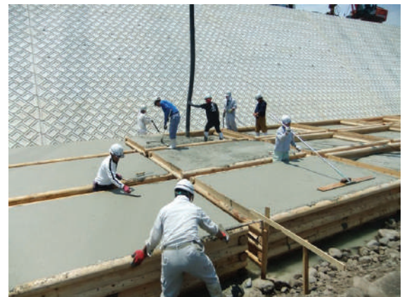
生コンクリート打設状況
