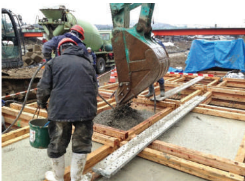
生コン打設状況
