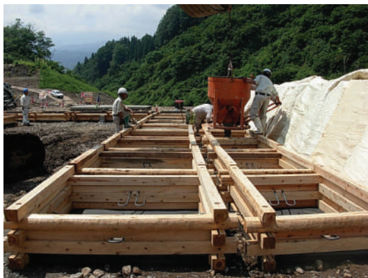
国交省 筑後川河川事務所 花月川 (ウッドロック工法+木工沈床)
