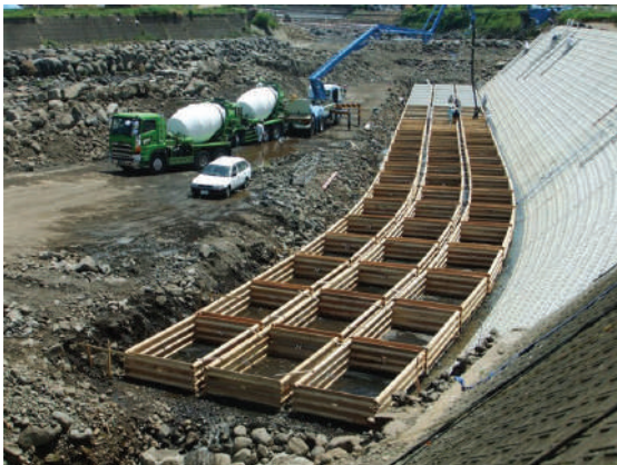
ユニット据付状況
