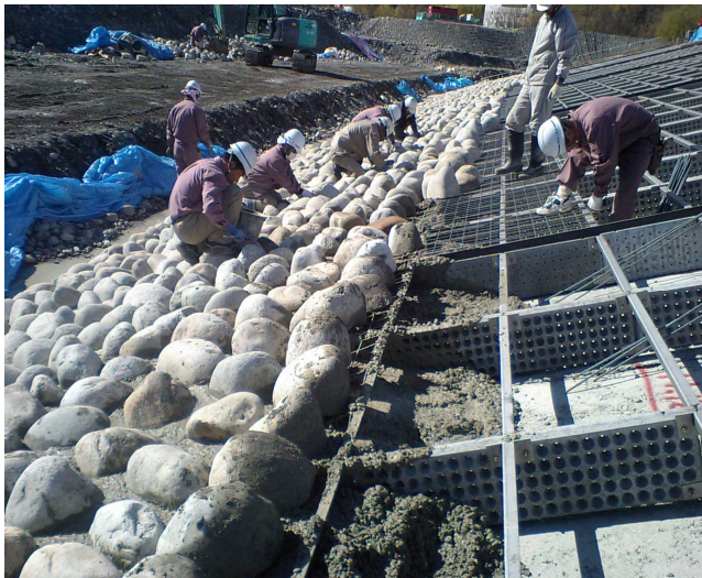
④ 生コン打設
