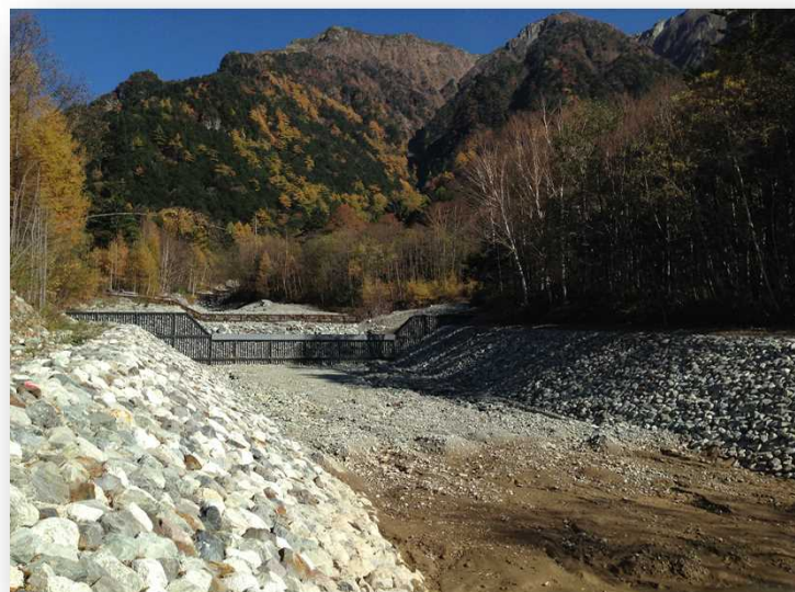
北陸地方整備局 松本砂防事務所 約2000㎡
