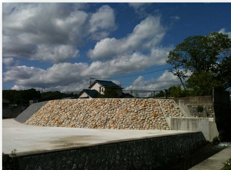
近畿地方整備局 猪名川河川事務所 150㎡
