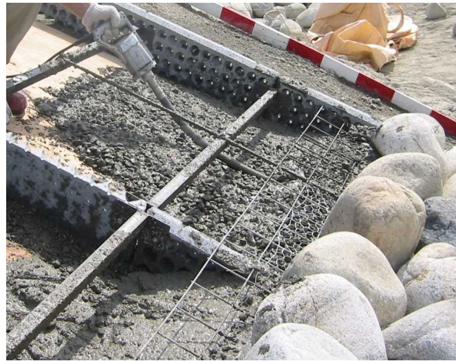
⑤ バイブレータ施工
