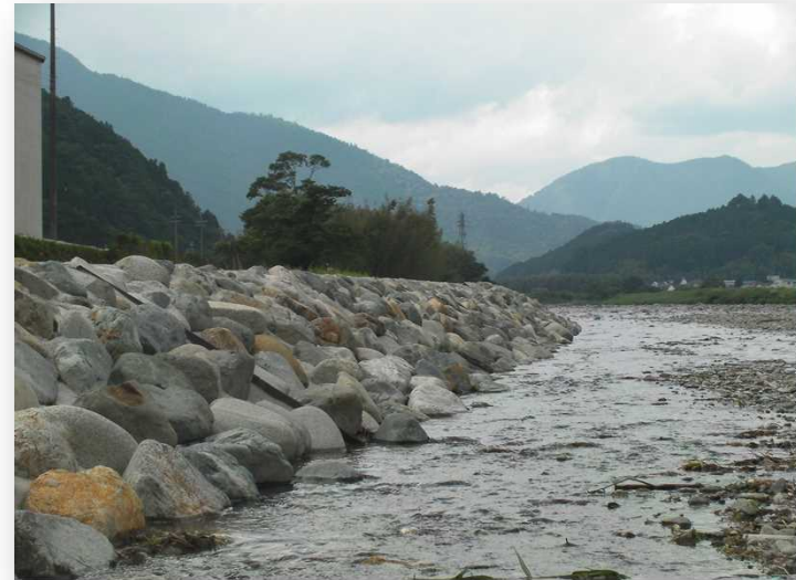
近畿地方整備局 姫路河川国道事務所 約3000㎡
