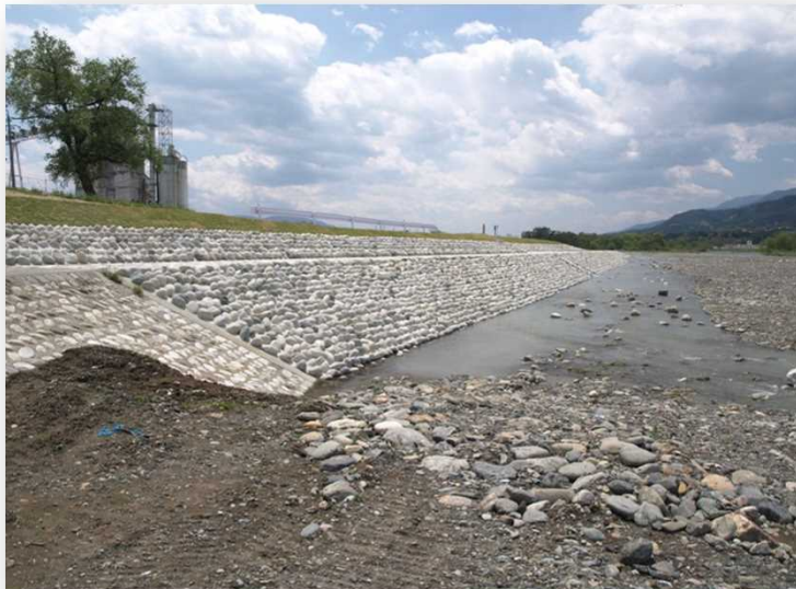
中部地方整備局天竜川上流河川事務所 約5000㎡
