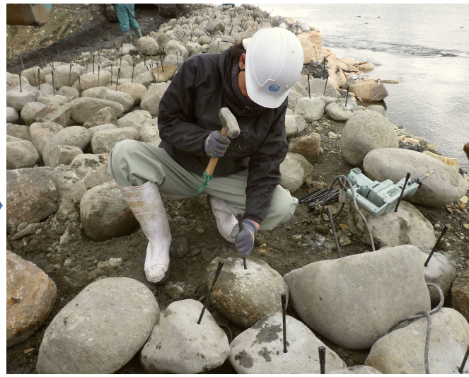
② アンカー取付け
