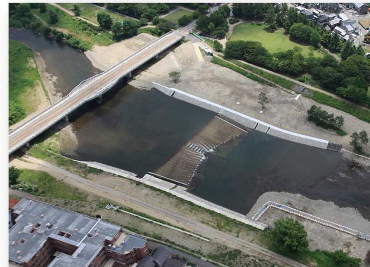
石川県 県央土木事務所 犀川 床止工、魚道工
