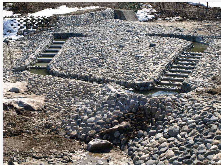
北陸地方整備局 松本砂防事務所 平川 魚道工
