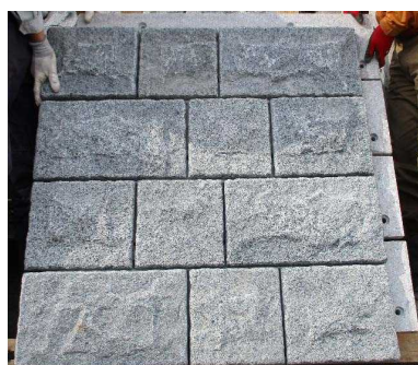
パネル据え付け(4段目)
