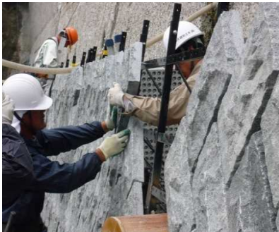
石材据付状況 横フレーム穴に寸切ボルトを入れ、ナットで固定
