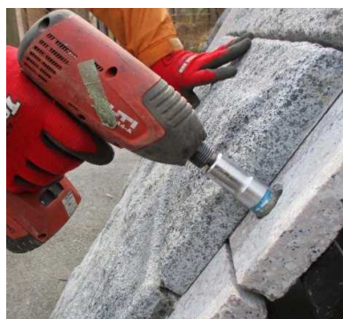
フレームにボルトにて取り付け
