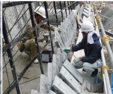
石材据付状況 横フレーム穴に寸切ボルトを入れ、ナットで固定
