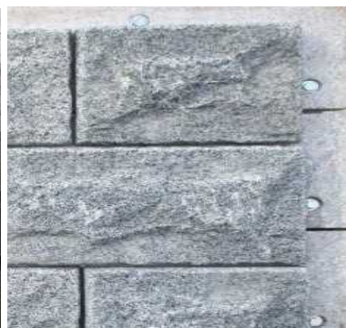
ボルト取り付け完了
