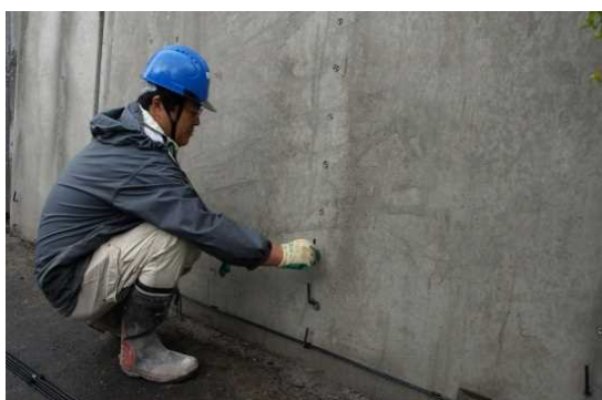
壁面金具取付状況
