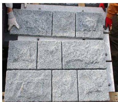
パネル据え付け(3段目)
