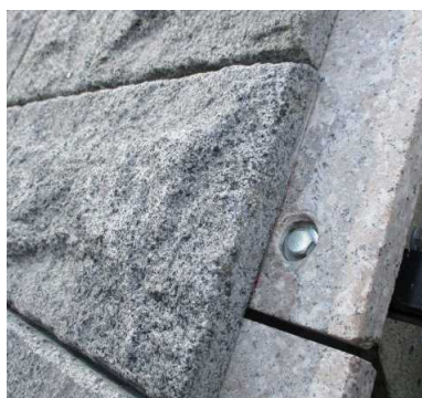
ボルト取り付け完了
