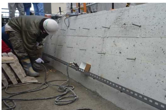
壁面金具取付状況
