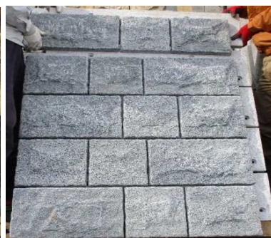
パネル据え付け(5段目)
