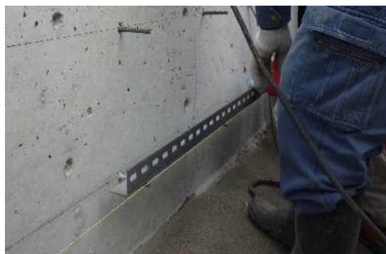
専用金具取付状況
