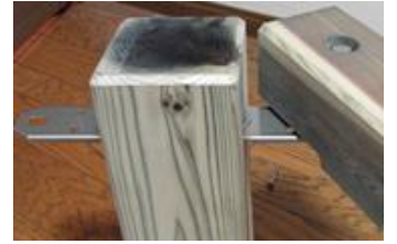
③ビーム材仮止め(写真左:直線区間、写真右:曲線区間)
