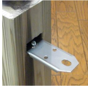
②親柱への連結金具固定
