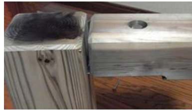
③ビーム材仮止め(写真左:直線区間、写真右:曲線区間)
