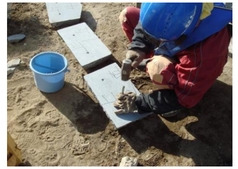
③ 化粧材(みかげ石)アンカー取付
