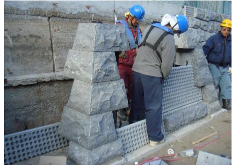
⑨ 隅石設置<張出し部>
