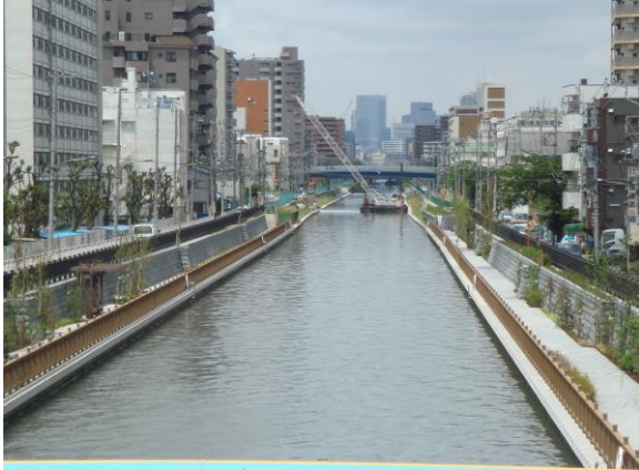
上流側(旧中川)より下流側(墨田川)を望む
