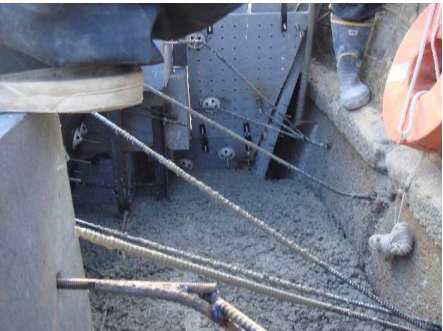
⑦ コンクリート打設<上段部>
