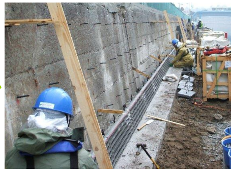
② 残存型枠設置、固定
