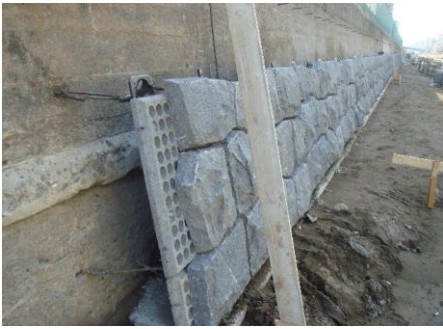
④ 化粧材(みかげ石)取付<下段部>
