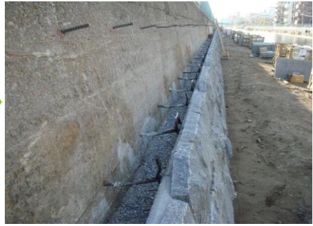
⑤ コンクリート打設<下段部>
