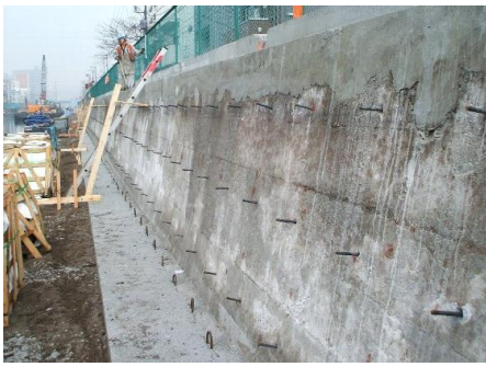
① 既設護岸チッピング、アンカー取付
