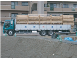
1、搬入 大型平：25基(100m 2 )/台
