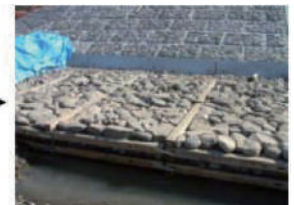
沈石 敷き並べ状況
