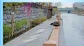
残存化粧材工法 ピアストーン
