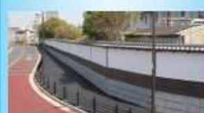
輸入石材販売工事 みかげ石
