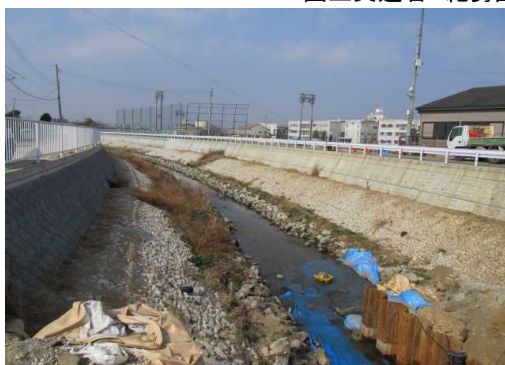
奈良県 米川(河川護岸工)
