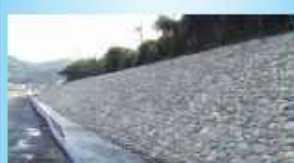
自然石張ブロック工法 レピーストーン
