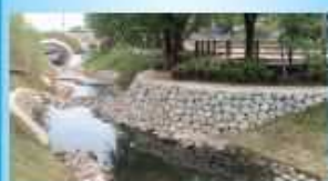
連結自然石空積工法 アンカービオストーン
