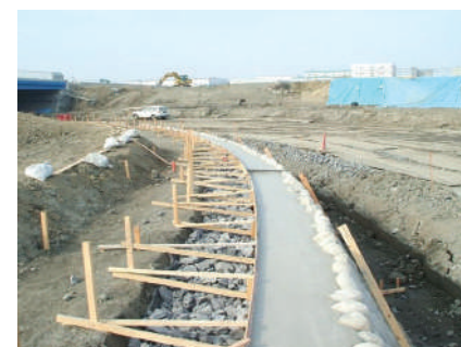
8、天端コンクリート打設 (現場によっては不要)
