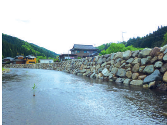
福井県 一乗谷川(巨石を使用した事例)
