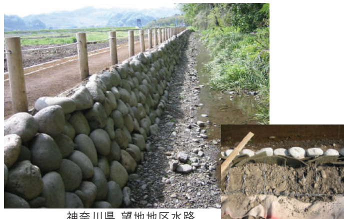
神奈川県 望地地区水路 (現場発生材を中詰め材として利用)
