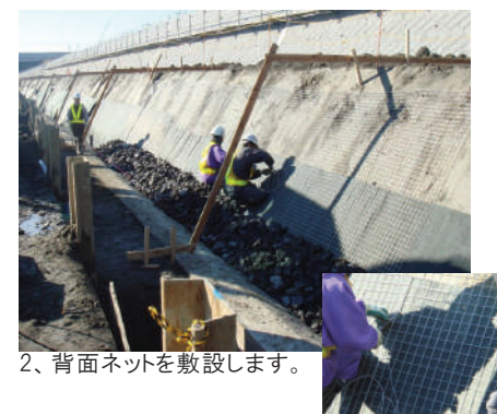
3、石材を所定勾配に設置し、最も安定した 位置を決めます。
