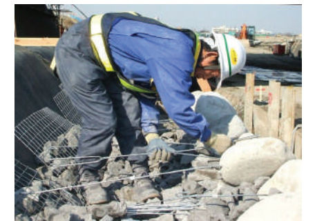
6、背面シャフトをネットにセットし、所定長さに 調節して、アンカーシャフトとジョイント金具で 連結します。
