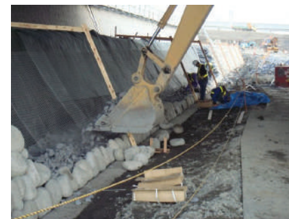
7、裏込材を投入します。 (以降3~8の工程を繰り返す)
