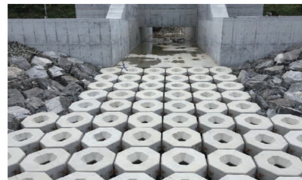
◇ 河川事例 : OR-I型2t : 連結 (大阪府泉佐野市 田尻川)
