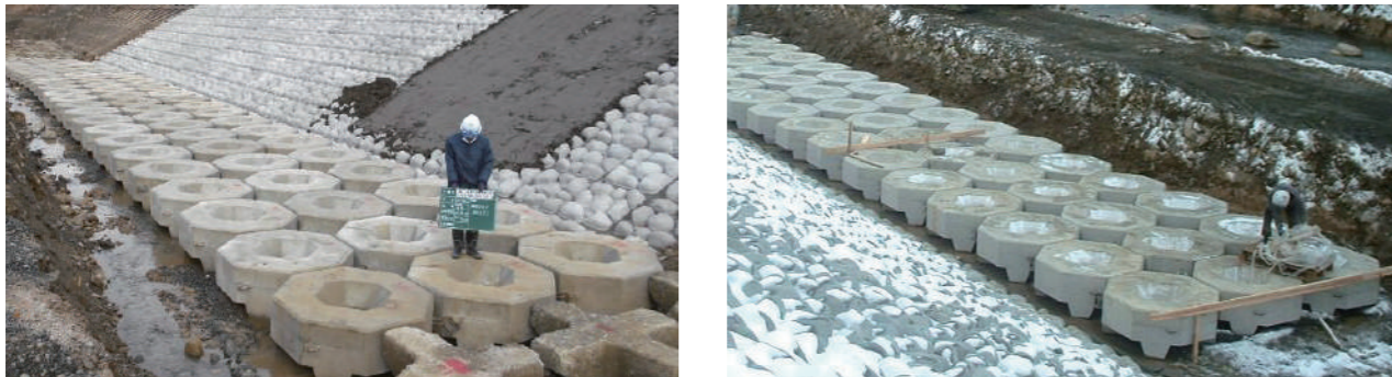
◇ 消波突堤事例：OR-I型4t（島根県太田市 久手港海岸）
