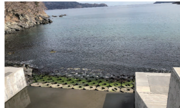
◇ 水門護床工 : OR-II型2t : 連結 (岩手県大船渡市 下甫嶺海岸)
