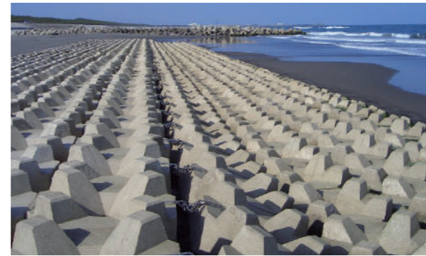
◇ 水門護床工 : OR-II型2t : 連結 (岩手県大船渡市 下甫嶺海岸)
