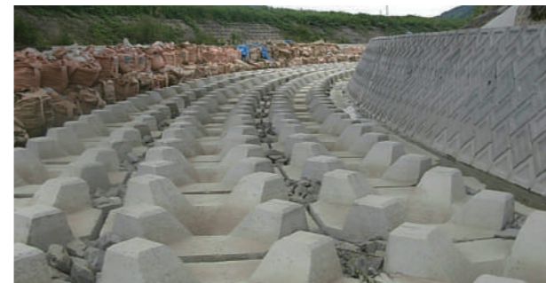
◇ 河川事例 : OR-I型2t : 連結 (大阪府泉佐野市 田尻川)
