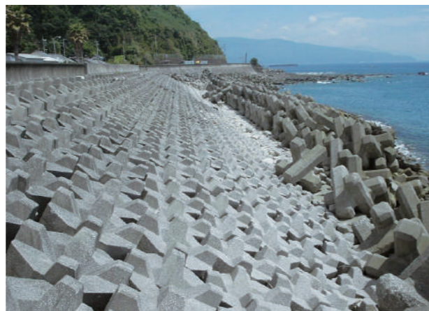
◇ 漁場整備囲礁工 : OR25t-I型溝型 (山口県 豊岡沿岸地区漁場整備 : 4地区)
