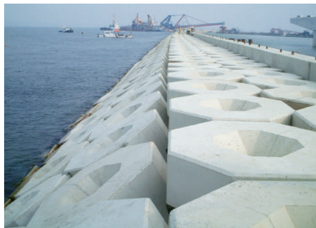
◇ 漁場整備囲礁工 : OR25t-I型溝型 (山口県 豊岡沿岸地区漁場整備 : 4地区)
