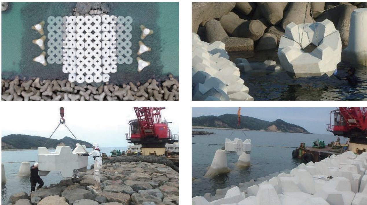
◇ 漁場整備 藻場礁事例：OR-I型4t溝型（三重県尾鷲市 長島地区）
