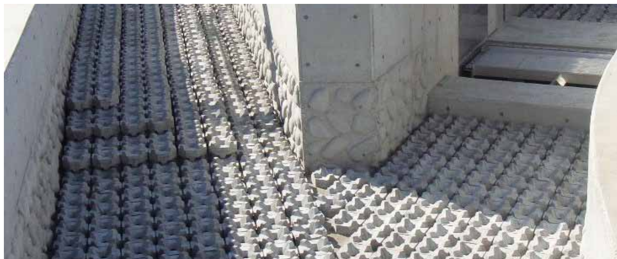
◇ 段積施工事例 オルサー (ミニタイプ) 魚道水路 : 1 ~ 4層積
