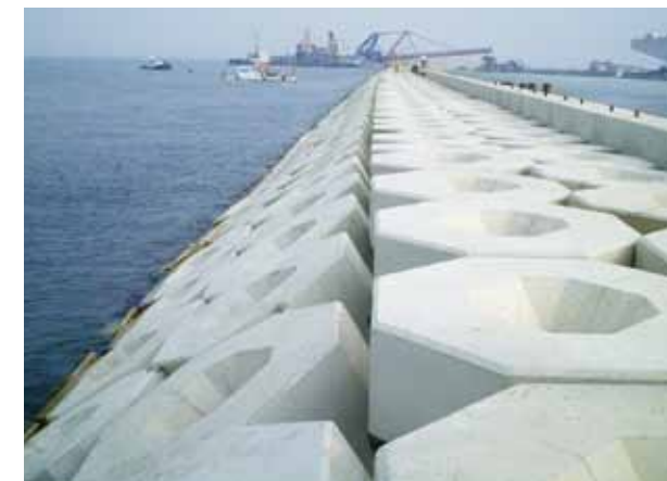
◇ 漁場整備囲礁工 : OR25t-I 型溝型 (山口県 豊岡沿岸地区漁場整備 : 4地区)
