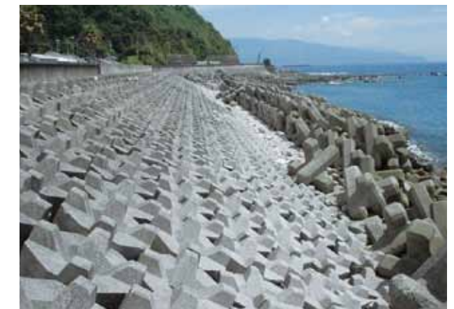
◇ 漁場整備囲礁工 : OR25t-I 型溝型 (山口県 豊岡沿岸地区漁場整備 : 4地区)
