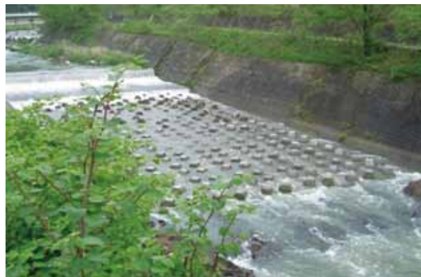
◇ 河川事例 (2) 護床工：OR-I型8t連結 (岐阜県 大里川)
