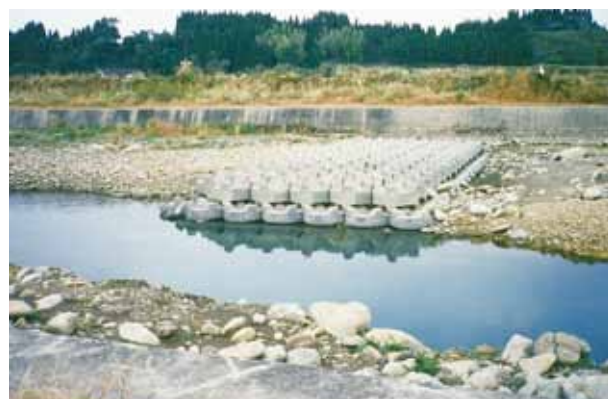
◇ 河川事例 (5) 護床工：OR-I型2t (宮崎県 川原川)
