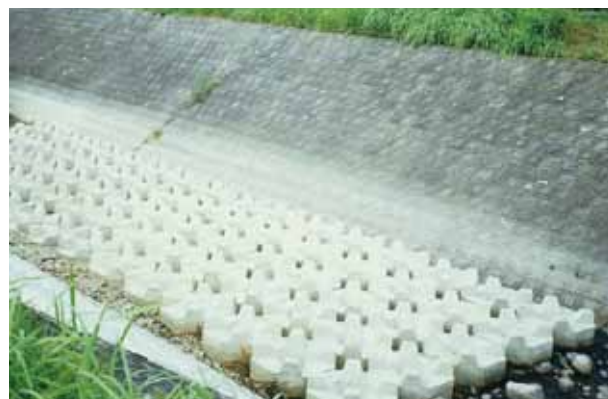
◇ 河川事例 (5) 護床工：OR-I型2t (宮崎県 川原川)
