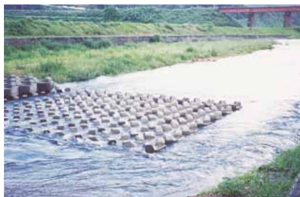
◇ 河川事例 (3) 水制工：OR-I型2t (宮崎県 清武川)
