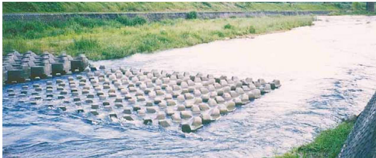
◇ 段積施工事例 オルサー (ミニタイプ) 魚道水路 : 1 ~ 4層積
