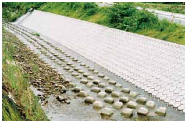
◇ 河川事例 (4) 護床工：OR-I型2t (宮崎県 辻の堂川)
