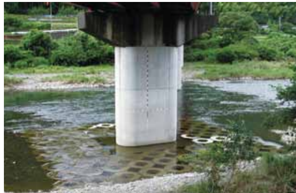
◇ 河川事例 (1) 橋脚基礎根固工：OR-II型5t連結 (和歌山県 日高川)
