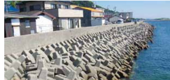
◇ 事例-13：護岸消波 多層乱積：G-8t (熊本県 ユニバーサル造船長洲工場 南護岸)
