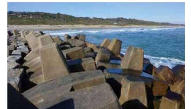
◇ 事例-11：ヘッドランド 多層積(B配列乱積)：G-8t (茨城県 鹿島灘(汲上地区)：No22ヘッドランド)
