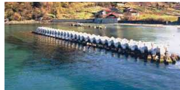
◇ 事例-9：離岸堤 多層積 (C配列)：G-12t (京都府宮津市 養老漁港海岸)
