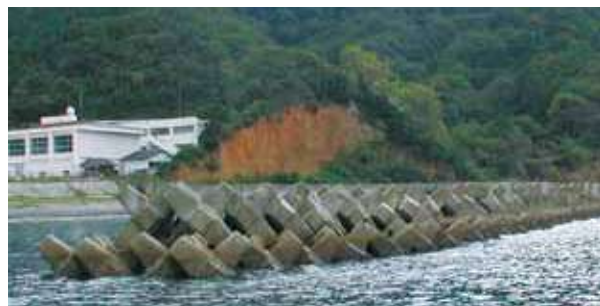
◇ 事例-7：離岸堤 多層積 (C配列)：G-5t (福井県 神子漁港海岸)
