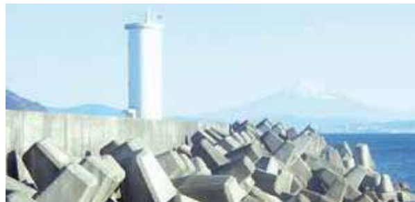
◇ 事例-10：傾斜消波堤 乱積：G-2t (長崎県諫早市 江の浦漁港消波堤)
