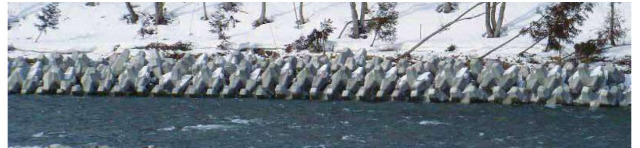
◇ 事例-2：河川護岸根固工：G-4t (秋田県北秋田土木 阿仁川米内沢地区護岸)
