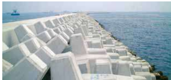
◇ 事例-7：道路消波 多層乱積：G-4t (岩手県久慈市 野田線広内地区護岸)
