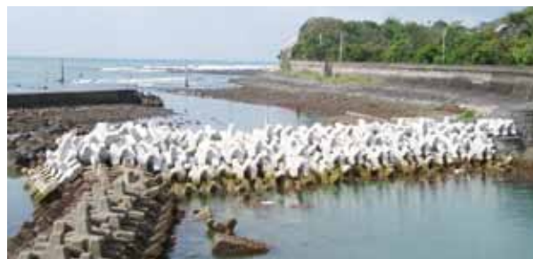
◇ 事例-11：防波堤消波工 多層乱積：G-80t (長崎県対馬地方局 豆酸漁港冲防波堤)
