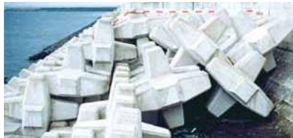
◇ 事例-6：護岸消波 二層被覆：G-15t (兵庫県神戸空港 造成護岸)
