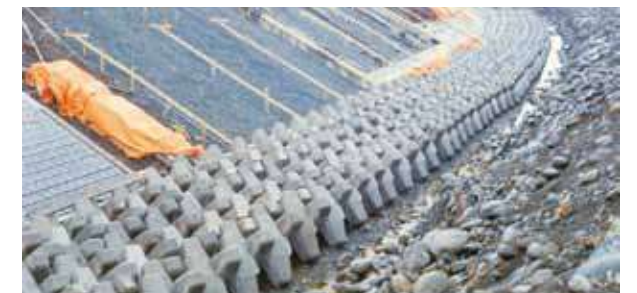
◇ 事例-6：河川護岸根固工：G-3t (国土交通省八代河川国道 球磨川下代瀬地区護岸)
