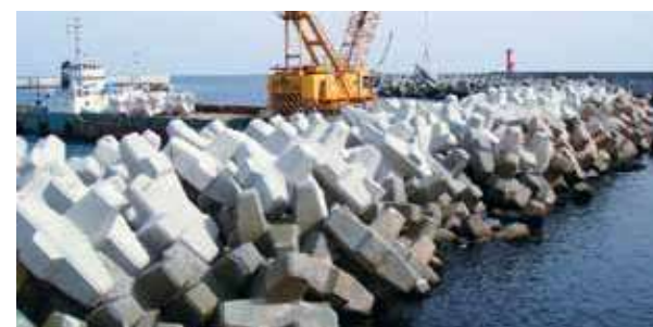
◇ 事例-1：防波堤遊水部消波工 乱積：G-25t (青森県 白糠漁港 (焼山地区) 防波堤・遊水部付き)
