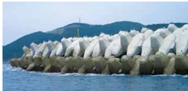
◇ 事例-11：防波堤消波工 多層乱積：G-80t (長崎県対馬地方局 豆酸漁港冲防波堤)
