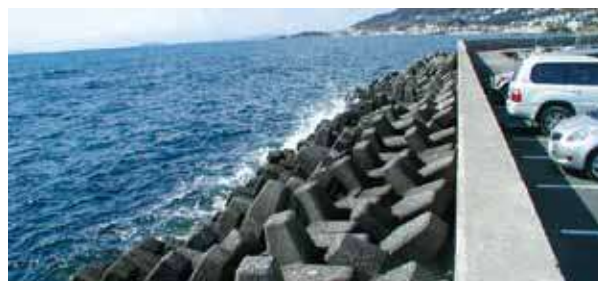
◇ 事例-10：護岸消波 多層乱積：G-6t (神奈川県 秋谷漁港護岸)
