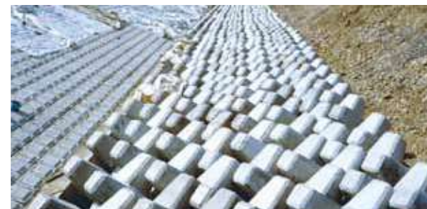
◇ 事例-5：河川護岸根固工：G-1t (国土交通省宮崎河川国道 本庄川金崎地区護岸)
