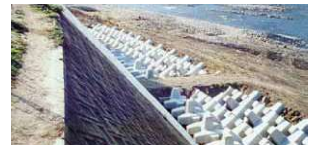
◇ 事例-8：河川護岸根固工：G-2t (宮崎県日南土木 酒谷川護岸)
