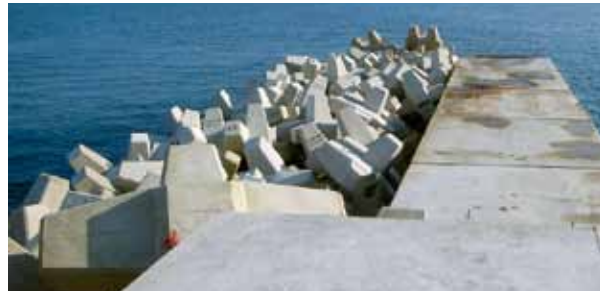
◇ 事例-7：防波堤消波工 乱積：G-5t (富山県黒部市 石田漁港防波堤)
