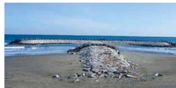
◇ 事例-11：ヘッドランド 多層積(B配列乱積)：G-8t (茨城県 鹿島灘(汲上地区)：No22ヘッドランド)
