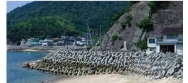
◇ 事例-13：護岸消波 多層乱積：G-8t (熊本県 ユニバーサル造船長洲工場 南護岸)
