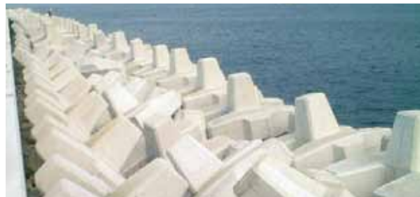
◇ 事例-8：護岸消波 多層乱積：G-5t (茨城県 林野海岸 (冷水地区))
