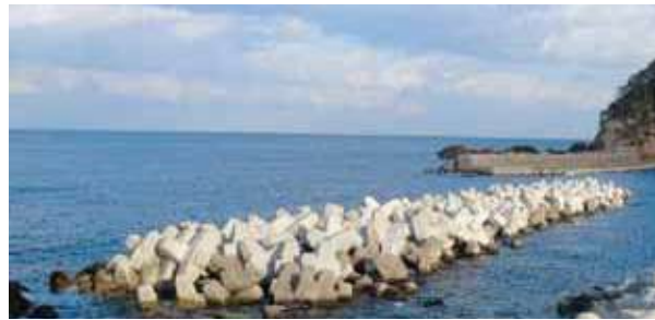
◇ 事例-5：防波堤消波工 乱積：G-8t (新潟県上越市 有間川漁港西防波堤)
