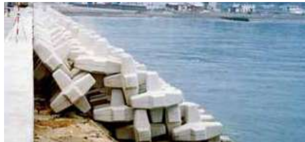
◇ 事例-5：護岸消波 二層被覆：G-5t (愛知県中部国際空港 造成護岸)
