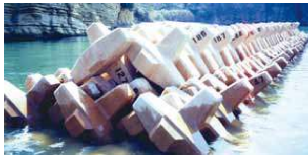
◇ 事例-4：離岸堤 多層乱積：G-4t (山口県 埴生港海岸)
