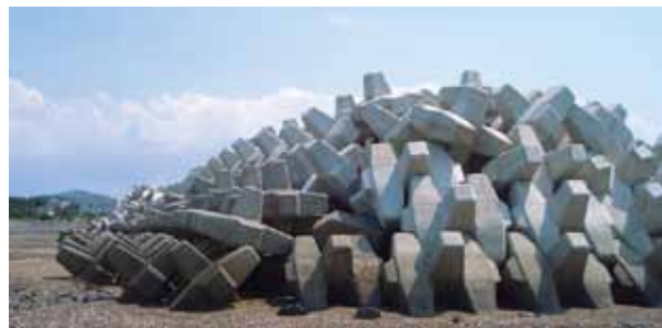
◇ 事例-4：離岸堤 多層乱積：G-4t (山口県 埴生港海岸)
