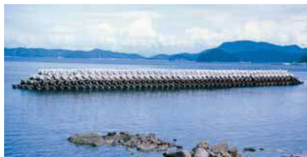
◇ 事例-7：離岸堤 多層積 (C配列)：G-5t (福井県 神子漁港海岸)
