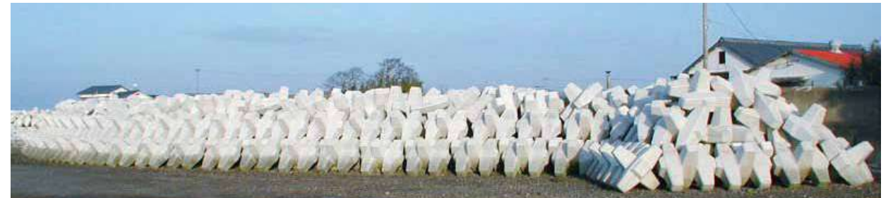
◇ 事例-18：護岸消波 多層乱積：G-4t (長崎県島原振興局 浜の田海岸)
