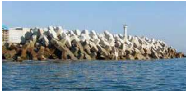
◇ 事例-6：防波堤消波工 乱積：G-80t、50t (千葉県鴨川漁港 前原防波堤)
