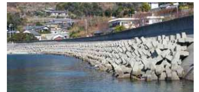
◇ 事例-17：護岸消波 多層乱積：G-2t (山口県 沖浦西港海岸)
