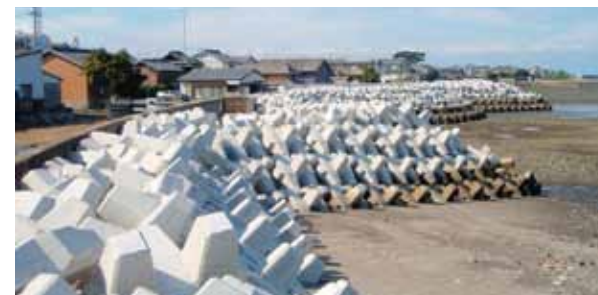
◇ 事例-18：護岸消波 多層乱積：G-4t (長崎県島原振興局 浜の田海岸)
