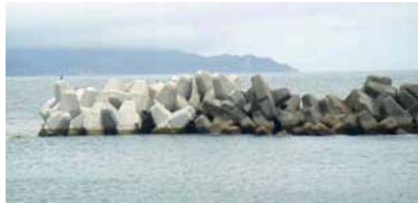
◇ 事例-8：防波堤消波工 乱積：G-40t (静岡県焼津漁港 小川南防波堤)
