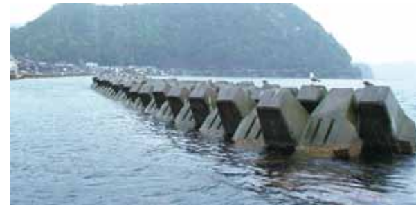
◇ 事例-10：離岸堤 多層積 (C配列)：G-15t (宮崎県 住吉海岸)
