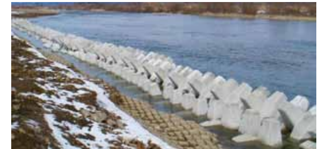
◇ 事例-4：河川護岸根固工：G-2t (国土交通省渡良瀬川河川 渡良瀬川白髭地区護岸)
