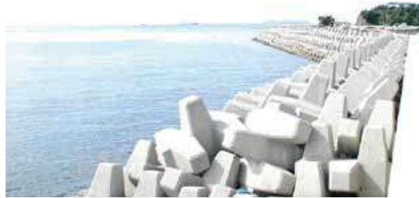
◇ 事例-3：護岸消波 二層被覆：G-3t (愛媛県伊予市 森漁港防波護岸)
