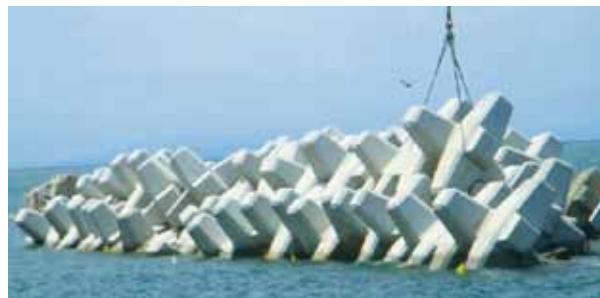
◇ 事例-5：離岸堤 多層乱積：G-40t (愛媛県伊方町 四つ浜漁港)
