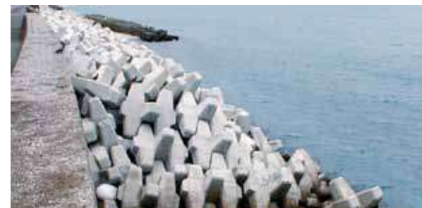
◇ 事例-16：護岸消波 多層乱積：G-4t (長崎県島原振興局 半田海岸)
