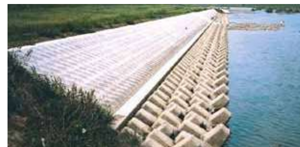
◇ 事例-7：河川護岸根固工：G-2t (宮崎県串間土木 福島川護岸)
