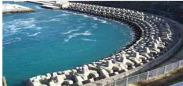
◇ 事例-4：護岸消波 二層被覆：G-3t (九州農政局鹿児島 出水地区造成護岸)
