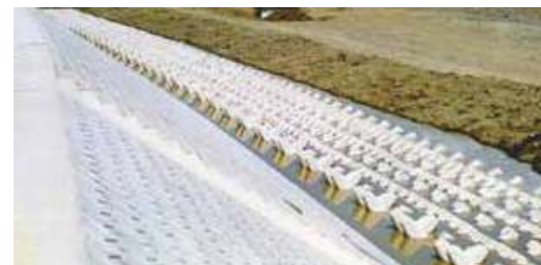
◇ 事例-7：河川護岸根固工：G-2t (宮崎県串間土木 福島川護岸)
