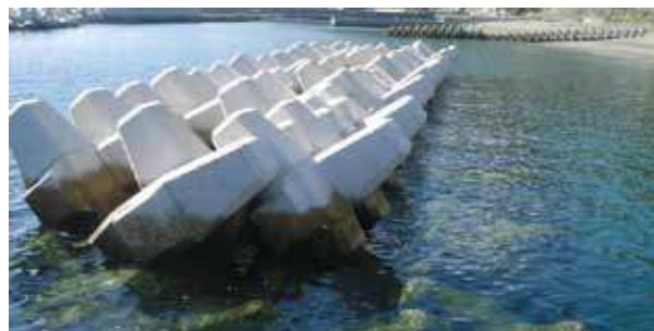
◇ 事例-6：離岸堤 多層積 (C配列)：G-5t (山口県 久賀港海岸)
