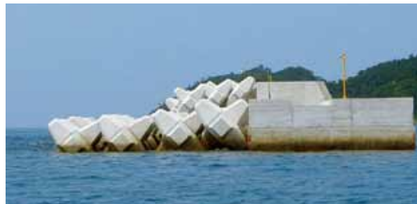
◇ 事例-11：防波堤消波工 多層乱積：G-80t (長崎県対馬地方局 豆酸漁港冲防波堤)
