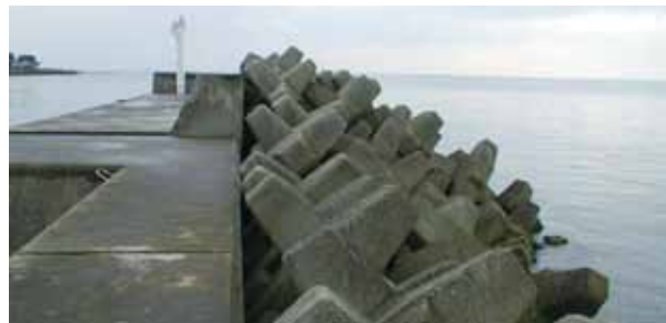
◇ 事例-9：防波堤消波工 乱積：G-60t (沖縄県宮古島 池間漁港離岸堤)
