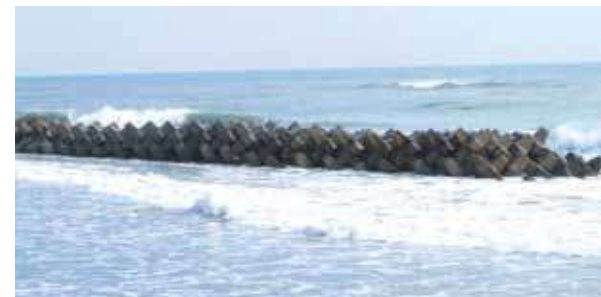
◇ 事例-11：ヘッドランド 多層積(B配列乱積)：G-8t (茨城県 鹿島灘(汲上地区)：No22ヘッドランド)
