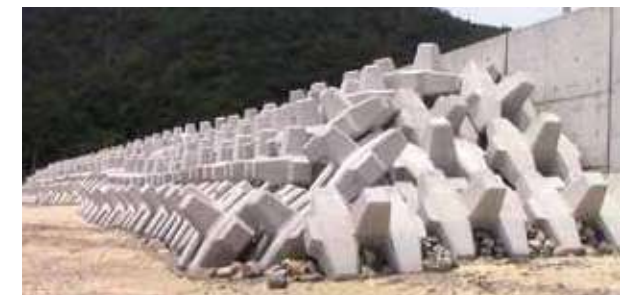
◇ 事例-17：護岸消波 多層乱積：G-2t (山口県 沖浦西港海岸)
