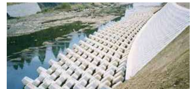
◇ 事例-8：河川護岸根固工：G-2t (宮崎県日南土木 酒谷川護岸)
