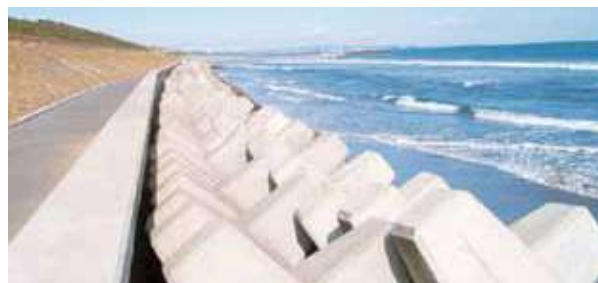
◇ 事例-10：護岸消波 多層乱積：G-6t (神奈川県 秋谷漁港護岸)
