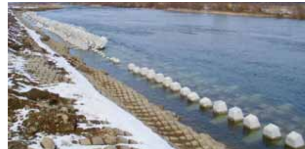
◇ 事例-3：河川護岸根固工：G-2t (国土交通省京浜河川 多摩川浅川高幡地区護岸)
