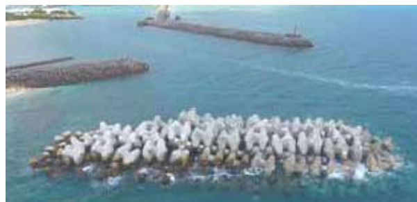
◇ 事例-11：防波堤消波工 多層乱積：G-80t (長崎県対馬地方局 豆酸漁港冲防波堤)
