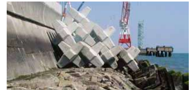
◇ 事例-15：護岸消波 多層乱積：G-4t (長崎県諫早土木 田結港海岸)
